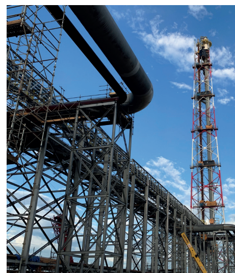
A torre da tocha foi instalada
