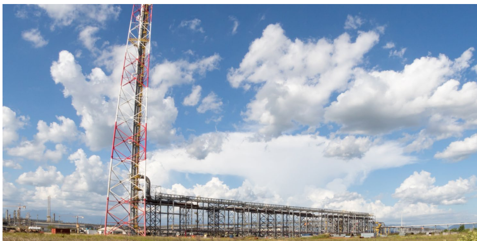
O teste de acendimento da tocha do GasLub foi um dos marcos nas obras em 2020
