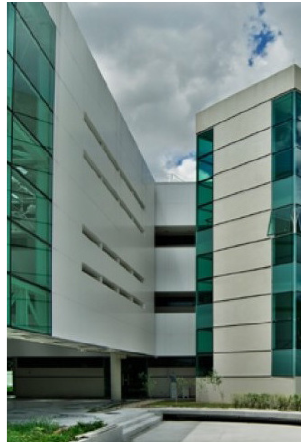
São Gonçalo receberá, antecipadamente, o moderno prédio do Centro de Integração
