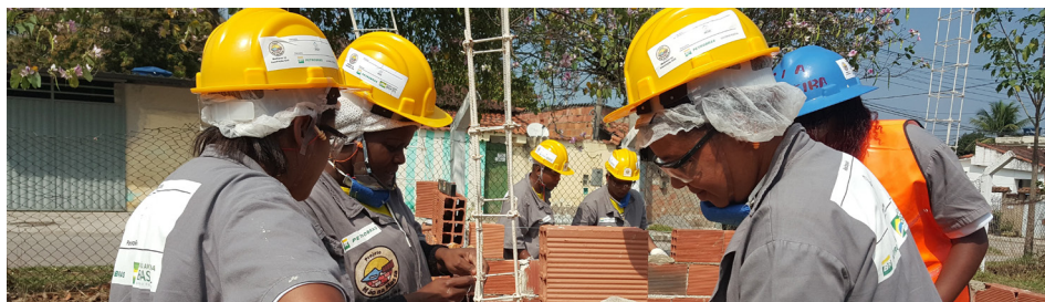
O Mão na Massa oferece aulas práticas em canteiros de obra
